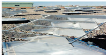
une banque de miroirs placés sur le toit de l'éco-centre permet l'éclairage naturel de l'ensemble des locaux
